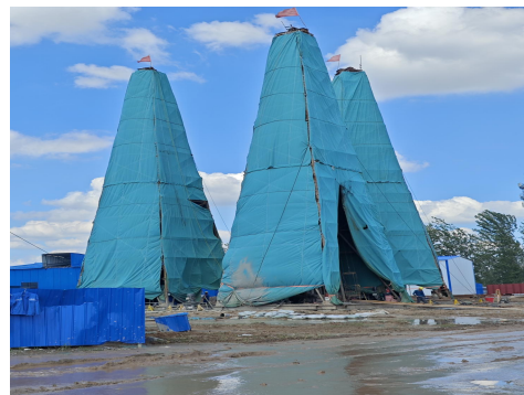
图 2.2-2：杨套楼工业场地副井现场照片
