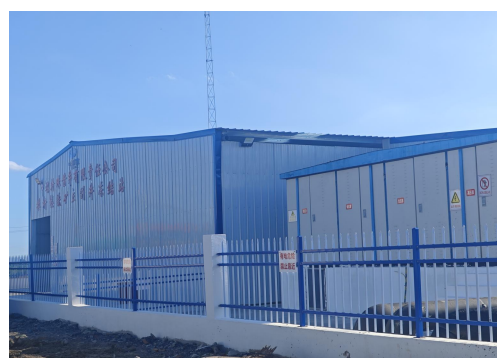
图 2.2-4：杨套楼工业场地冻结站现场照片
