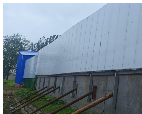
图 2.2-6：杨套楼工业场地北侧声屏障照片
