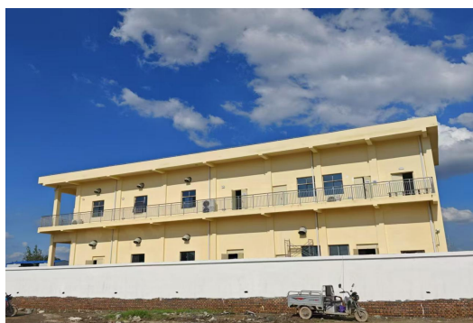
图 2.2-1：杨套楼工业场地变电站现场照片
